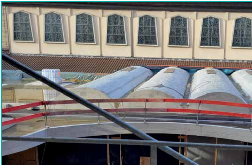
Bei einer Rohbaubegehung konnte der Projektausschuss der St. Nicolai-Gemeinde einen Blick vom neuen Wohnhaus aus auf das gewölbte Dach des zukünftigen Gemeindesaals werfen.
